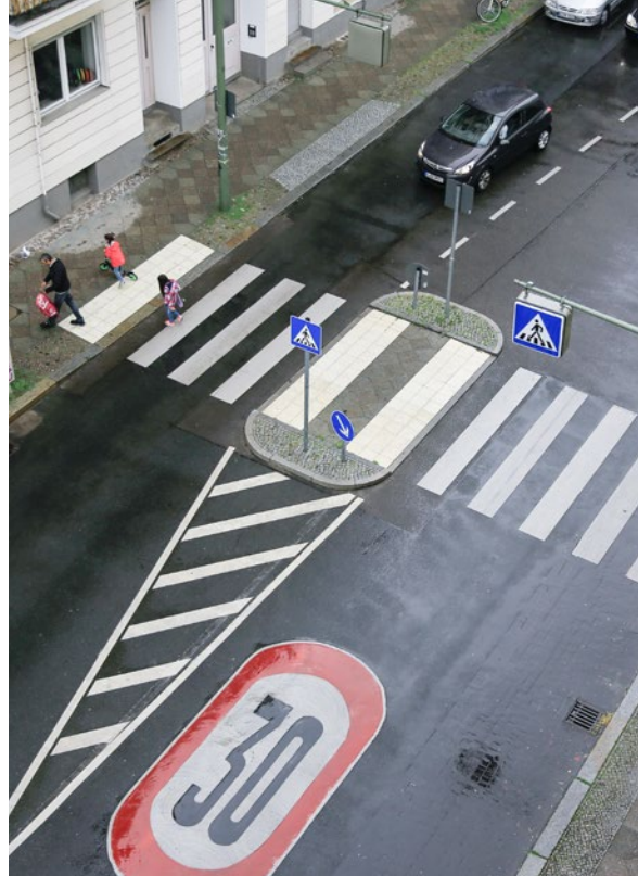
Die Kombination einer Mittelinsel mit einem FGÜ ist für Fußgänger*innen am sichersten.
