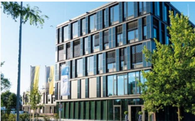
Im Neubau des ZSW in Stuttgart sind CIGS-Dünnschichtsolarmodule in die Fassade integriert. Die Module sind zwischen den Fenstern statt Alu-Abdeckungen platziert – auf diesem Foto sehr gut sichtbar, real kaum.
