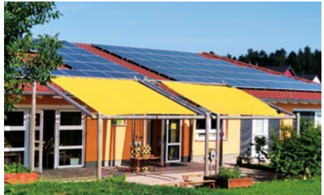
In Schömberg (Kreis Calw) wurden beim Neubau des Kindergartens alle geeigneten Dachflächen mit PV-Modulen belegt. Quelle: DGS
