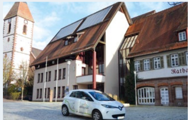
Solarstrom von der kommunalen PV-Anlage wird in Ebhausen (Landkreis Calw) direkt zum Laden des Elektro-Bürgerautos verwendet.
