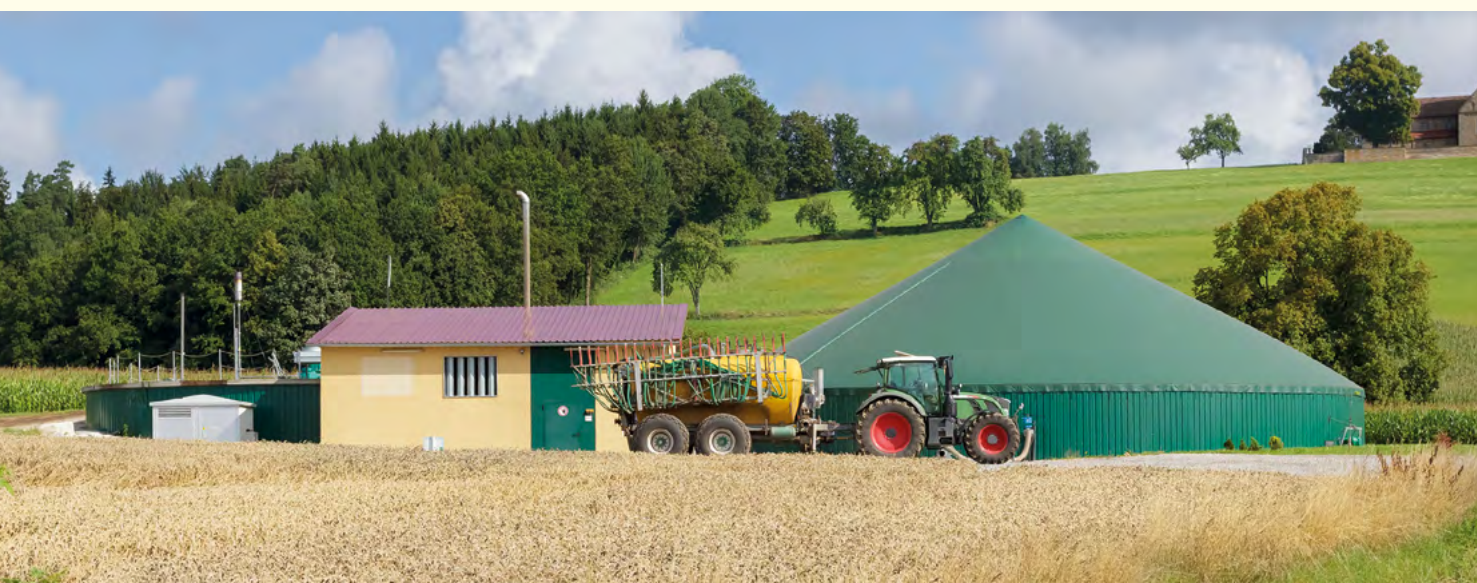
Bild: Biogasanlage (© ThomBal/stock.adobe.com)
